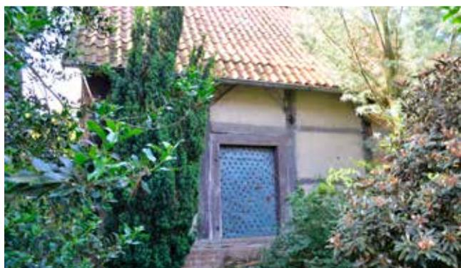
Abb. 132: Fachwerk-Wandständerbau in Hochrahmgefüge mit durchgezapften Ankerbalken (ca. 17 Jh.), Hauptstraße 39
