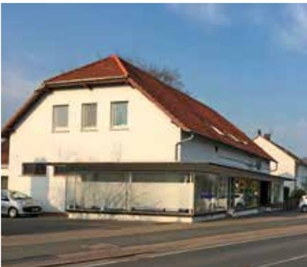
Abb.254: Veränderung im Bereich der Fenster- und Türöffnungen und der Türüberdachung sowie der Fassadengestaltung
