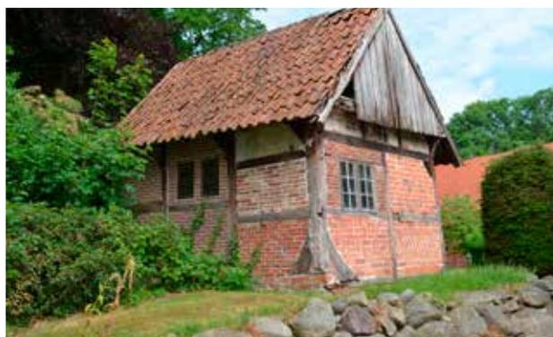
Abb. 133: Fachwerk-Wandständerbau in Hochrahmgefüge mit durchgezapften Ankerbalken (ca. 17 Jh.), Hauptstraße 83
